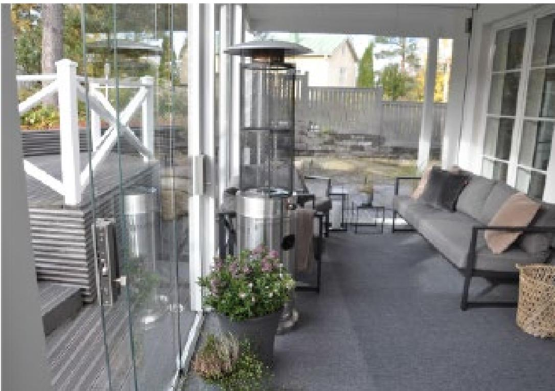
Die Lumon Verglasungssysteme bestehen aus zwei horizontalen Aluminiumprofilen, die an der Balkondecke und dem Boden, der Brüstung oder einem Geländer befestigt werden. Die gehärteten Glasscheiben sind an den Profilen durch separate Mechanismen befestigt, die es ermöglichen, die Scheiben zu verschieben und zu drehen (Lumon Dreh-Schiebe-System) oder nur zu verschieben (Lumon Schiebesystem).
