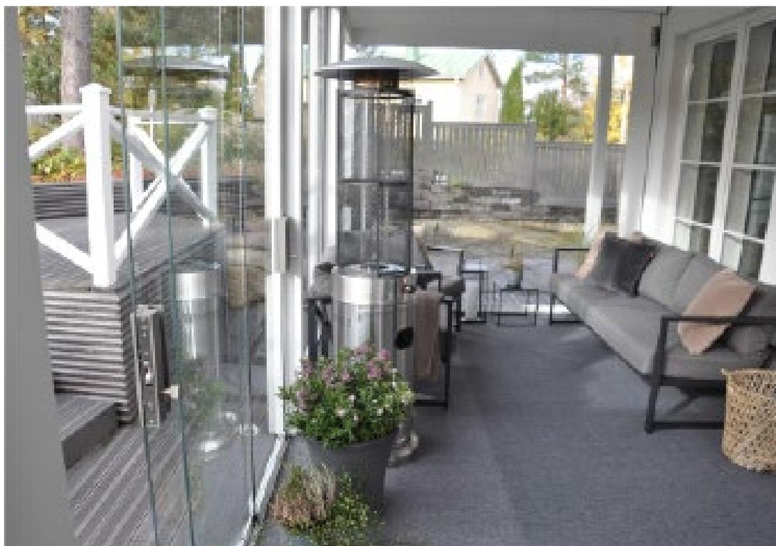
Los sistemas de acristalamiento y cerramiento de Lumon constan de dos perfiles de aluminio horizontales que se fijan al techo y al suelo del balcón, parapeto o a una barandilla. Las hojas de vidrio templado se fijan a los perfiles mediante unos mecanismos independientes que permiten deslizar y girar las hojas (Lumon Cristales Abatible) o solo deslizarlas (Lumon Cristales Corredera).
